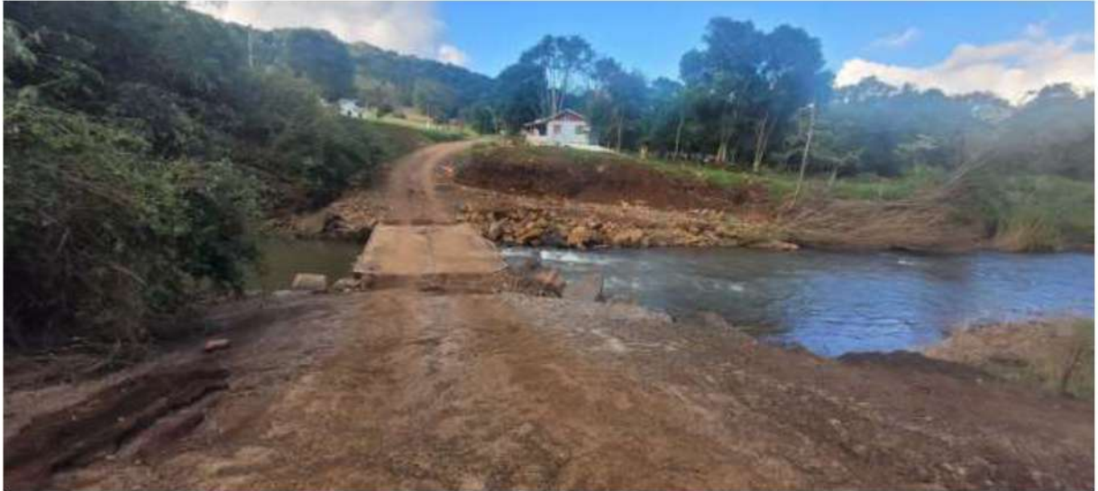
Figura 24: Ponte sob o Rio Três Voltas na Rua São Francisco Xavier
