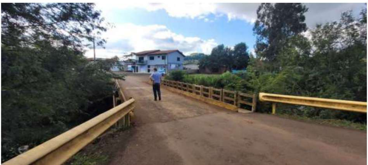
Figura 23: Ponte sob o Rio Três Voltas na Rua José Sheid
