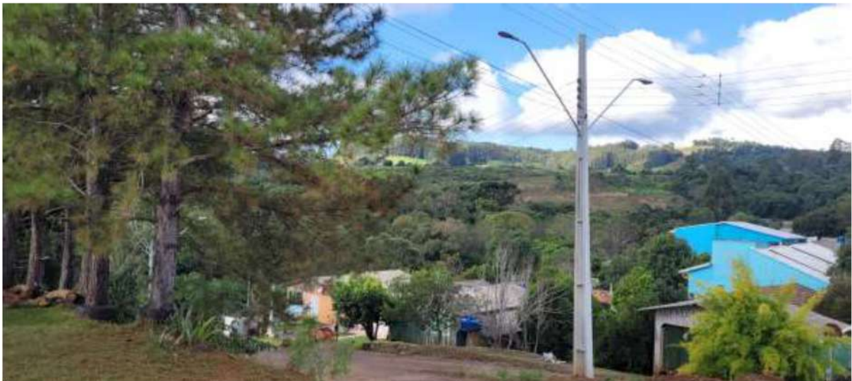
Figura 46: Infraestrutura urbana com rede elétrica
