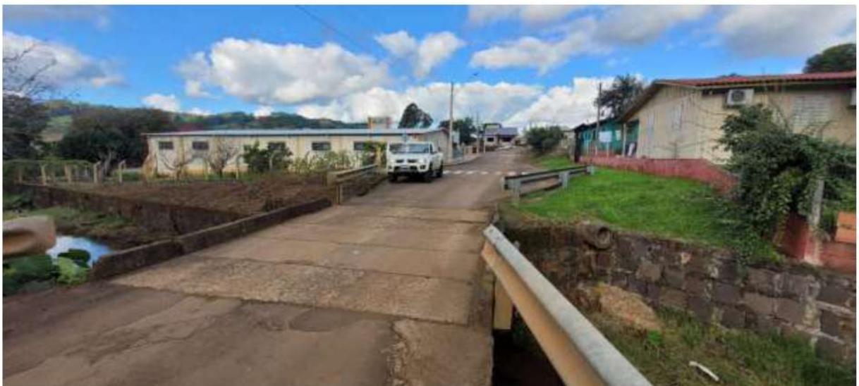
Figura 22: Ponte sob a canalização aberta na Rua Santa Clotilde
