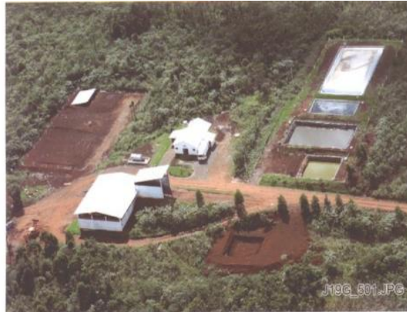
Figura 10.10 - Aterro Sanitário da empresa TUCANO na cidade de Anchieta – SC. Fonte: Tucano
