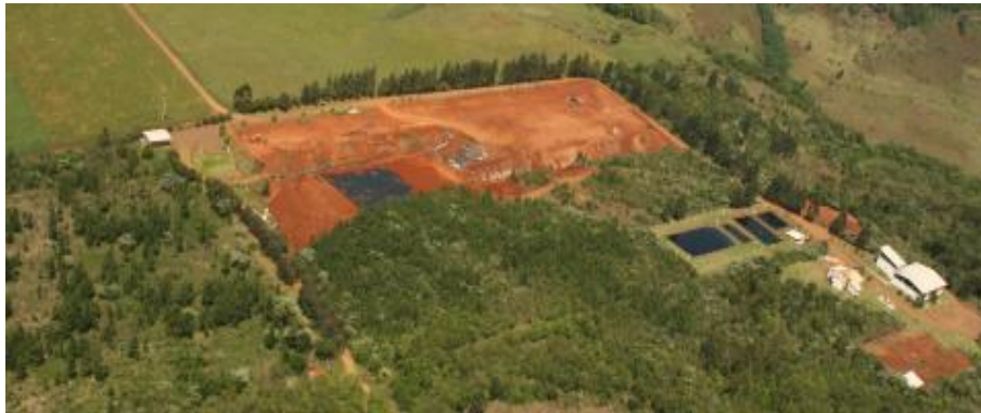
Figura 10.8 - Aterro Sanitário da empresa TUCANO na cidade de Anchieta – SC. Fonte: Tucano
