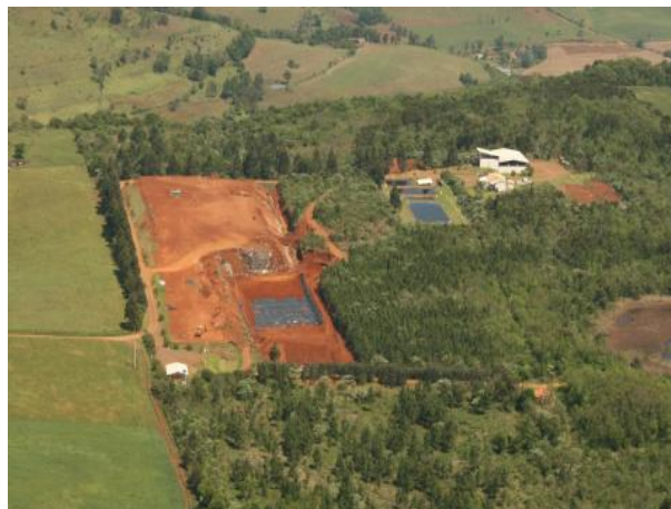
Figura 10.9 - Aterro Sanitário da empresa TUCANO na cidade de Anchieta – SC. Fonte: Tucano
