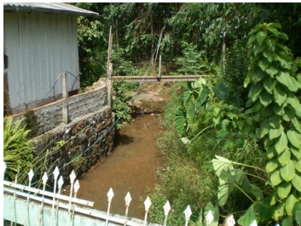
Figura 9.7 - Ocupações às margens de córrego.
