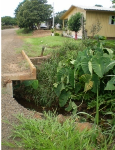
Figura 9.5 - Ocupações às margens de córrego.
