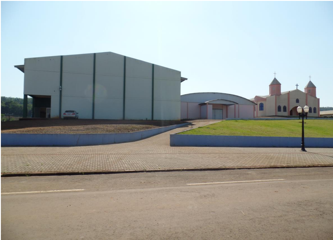
Figura 27. Ginásio de Esportes Afonso Fritzen, junto a Praça de São Bernardino.
