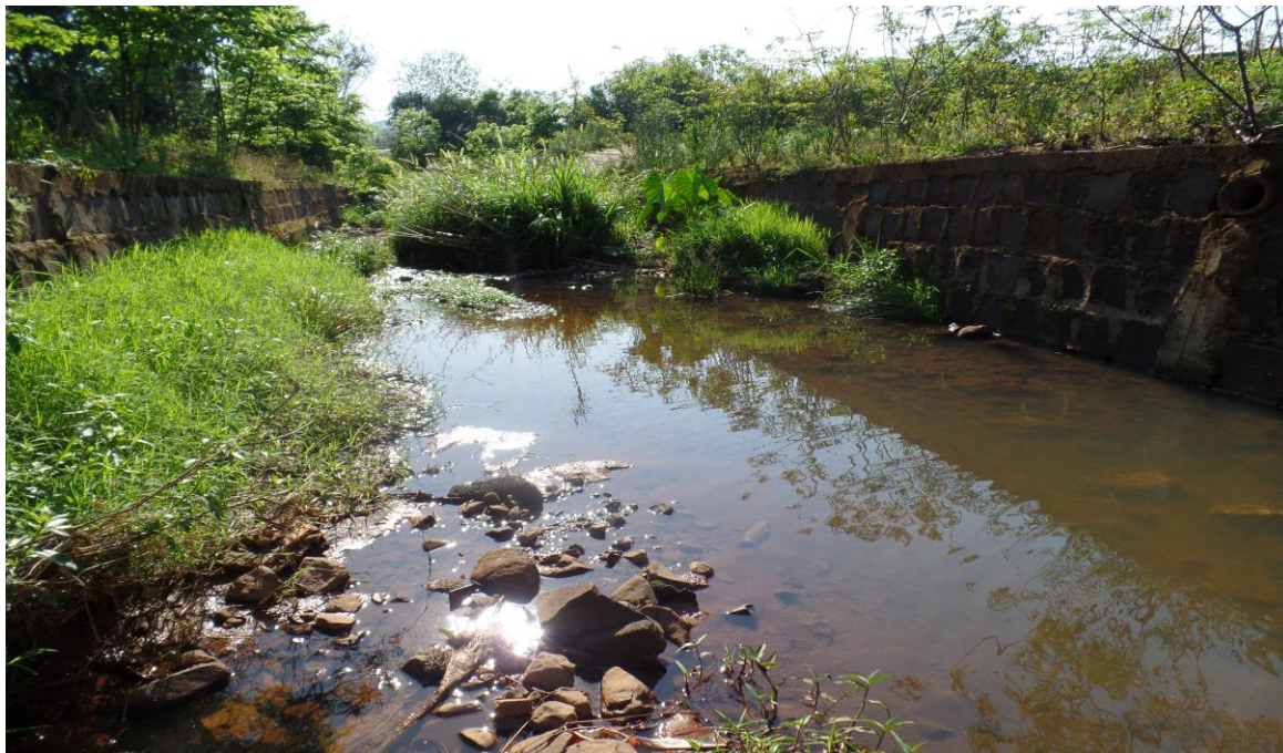
Figura 16. Imagem de material de construção lançado na Sanga.
