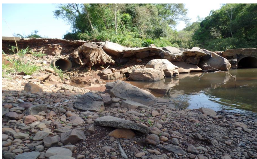
Figura 19. Imagem da cabeceira da Ponte baixa sobre o Rio Três Voltas.
