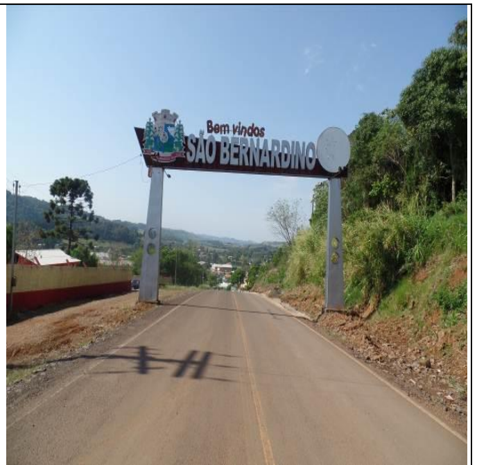
Figura 7. Portal de acesso ao município (entrada principal)
