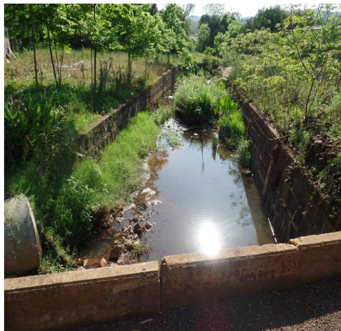
Figura 13. Ponte Rua Verônica Scheid.
